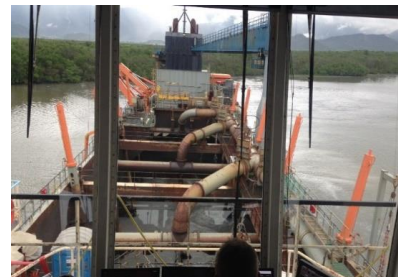
Figura 2 - Operação de dragagem da abertura da CAD
