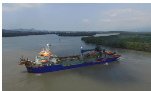
Figura 4 - Draga Ham 316 trabalhando na abertura da CAD
