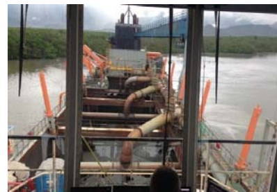
Figura 2 - Operação de dragagem da abertura da CAD
