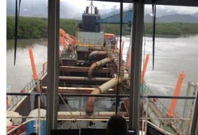
Figura 2 - Operação de dragagem da abertura da CAD
