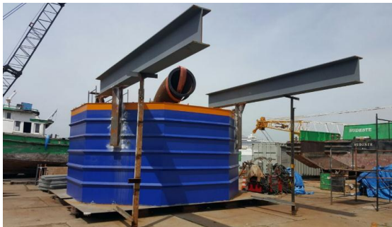
Figura 5 - Fabricação do difusor (Equipamento auxiliar despejo na CAD)
