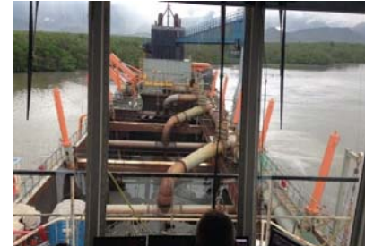
Figura 2 - Operação de dragagem da abertura da CAD
