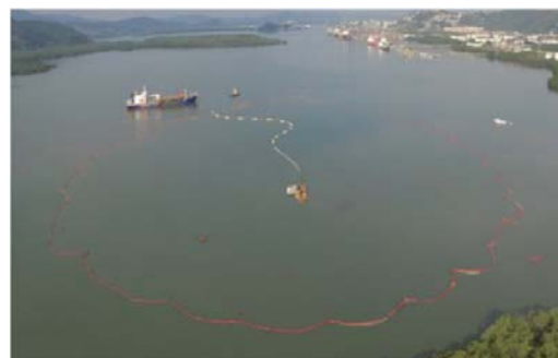
Figura 8 - Operação de disposição com abrangência da cortina de silte
