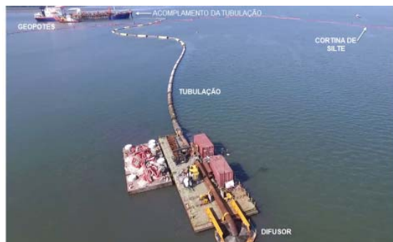
Figura 7 - Operação de disposição de material Dragado na CAD. Em primeiro plano Difusor para deposição
