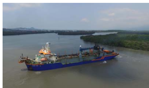
Figura 4 - Draga Ham 316 trabalhando na abertura da CAD
