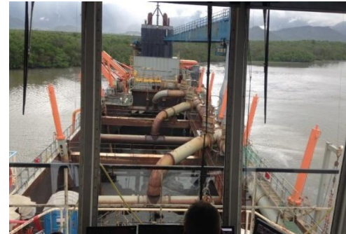
Figura 2 - Operação de dragagem da abertura da CAD
