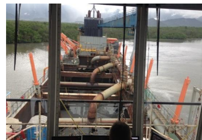
Figura 2 - Operação de dragagem da abertura da CAD
