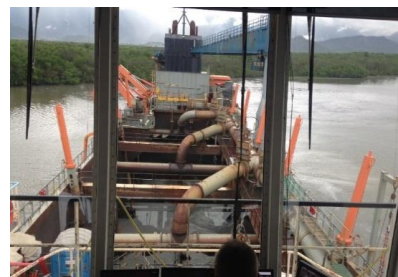
Figura 2 - Operação de dragagem da abertura da CAD
