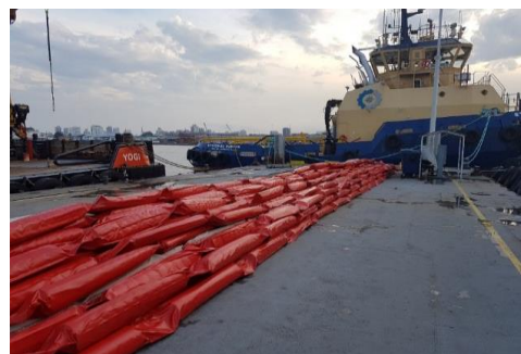
Figura 6 - Cortinas de silte fabricadas para cercamento da área de despejo da CAD
