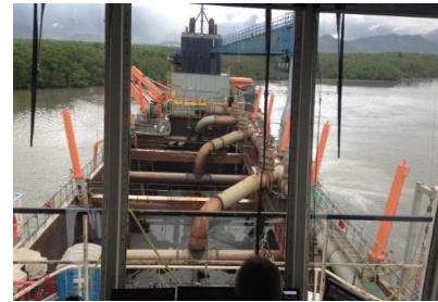
Figura 2 - Operação de dragagem da abertura da CAD
