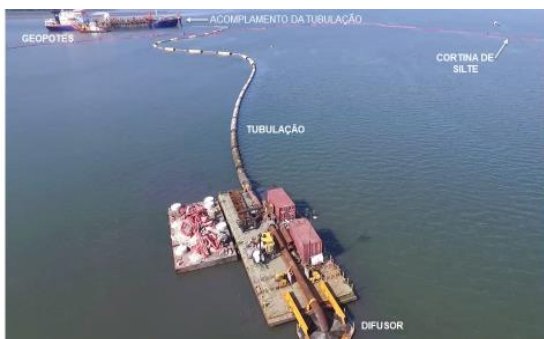
Figura 7 - Operação de disposição de material Dragado na CAD. Em primeiro plano Difusor para deposição
